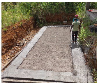
Semelle pour la pose des panneaux
