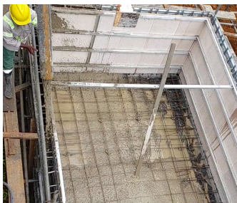
Coulage du béton
